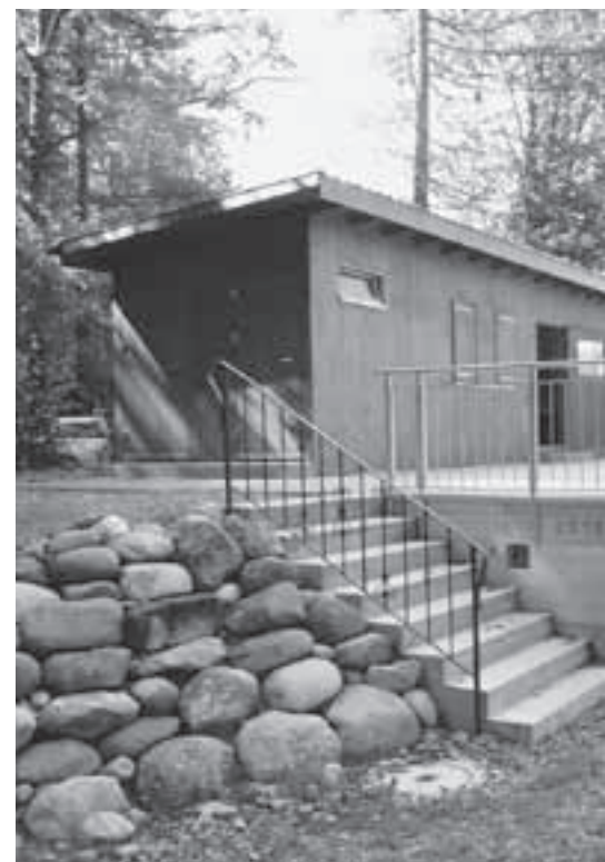
Das Herzstück der neuen Bauten ist das neue Vereinsgebäude
