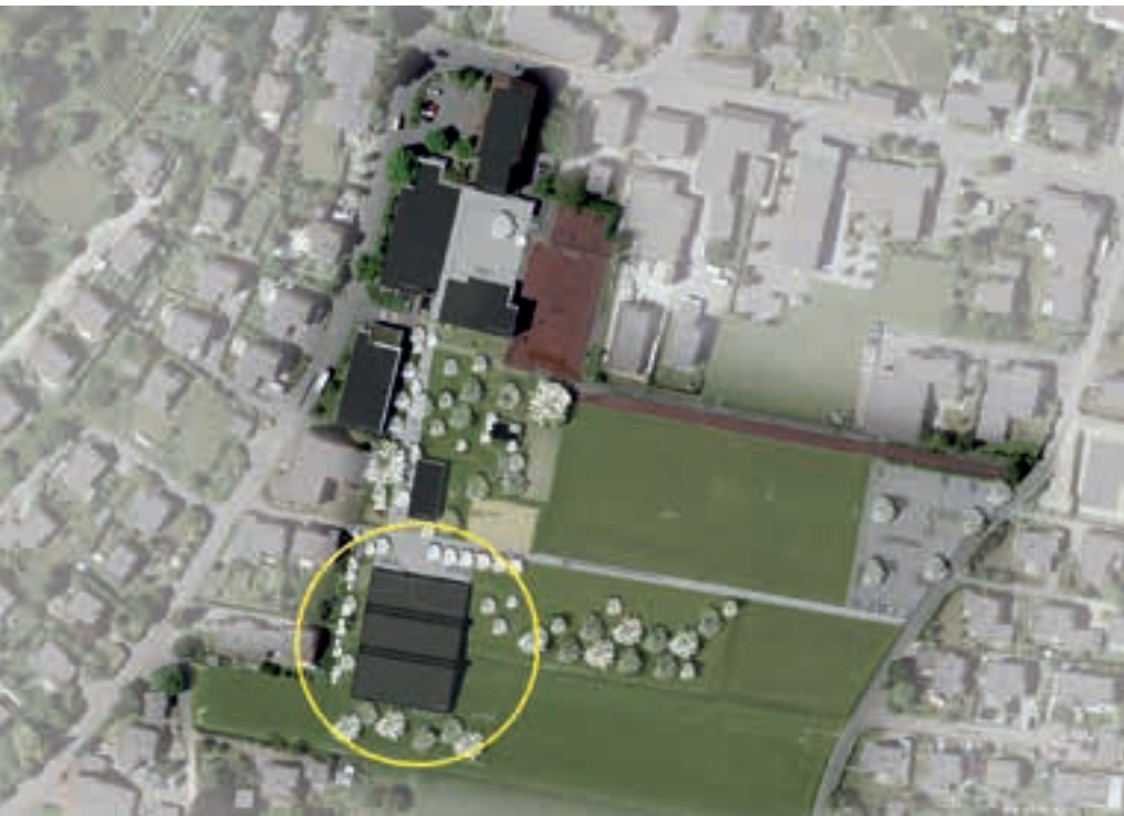
Die Sporthalle ist gut in die Infrastruktur der Schule integriert
