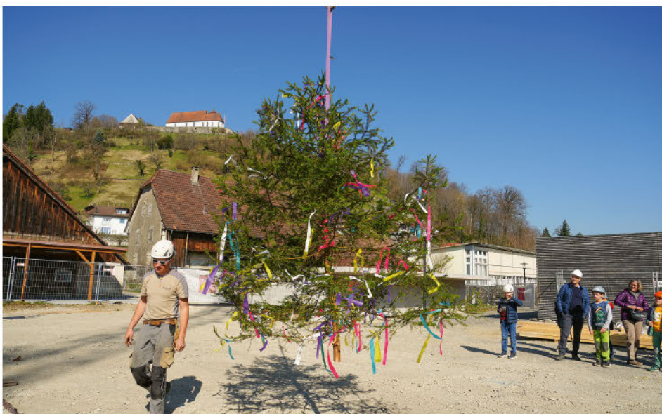
der Kran setzt an
