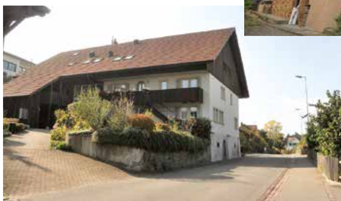
Hinterdorfstrasse 11 ehemalige Herberge
