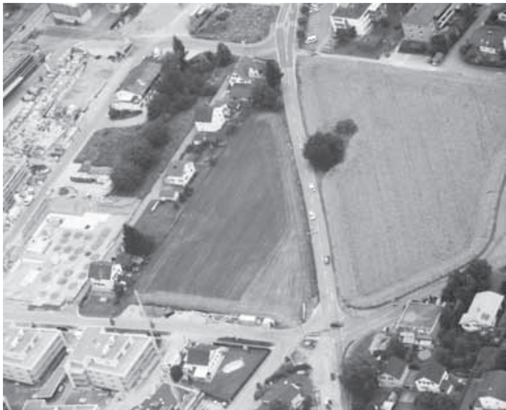
Die Sanierung der Schafisheimerstrasse bedarf Investitionen in der Höhe von 340'000 Franken.
