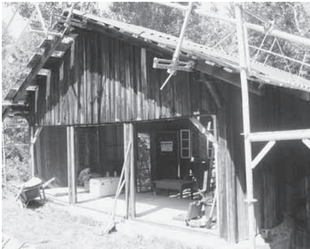
Das alte Schützenhaus wird saniert
