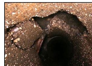
Undichte Kanalisation
