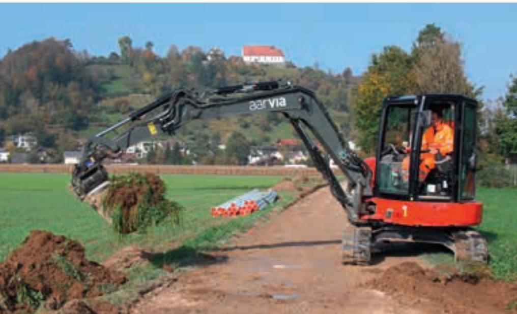
Seenerweg als Baustelle: Bagger ist fleissig an der Arbeit
